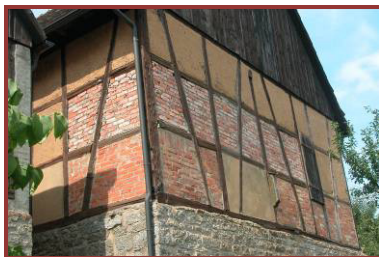
Mauerwerk-Instandsetzung am Grünkernmuseum
